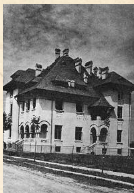
Clădirea Laboratorului de chimie, construit între 1925 și 1927
